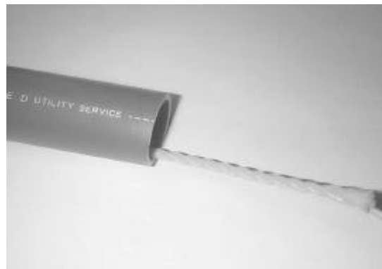
CONDUIT WITH ROPE
